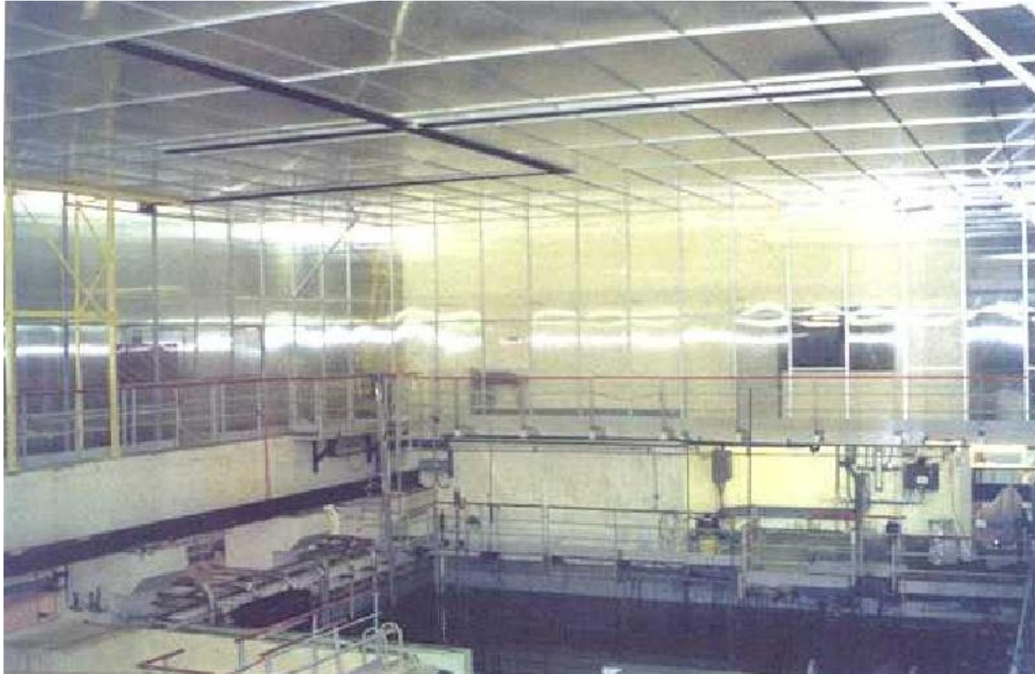
► Chantier Piscine de Bugey 1
