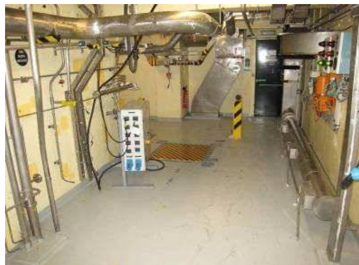
Voie sèche : 32 BâG en cellule 800
