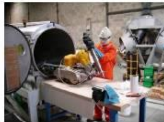
ROBOT CHARLI D'INTERVENTION DANS LES LIPOSO (perçage des rétentions de sodium)
