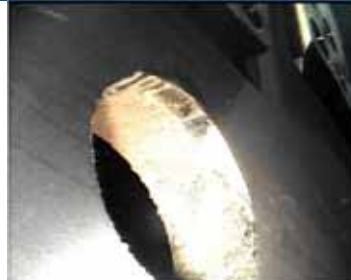
Trous réalisés dans la virole du coeur et l'écran thermique à SONGS1 pour lever les pièces
