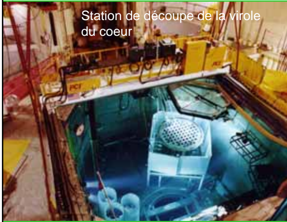
Cloisonnement du cœur (baffle)
